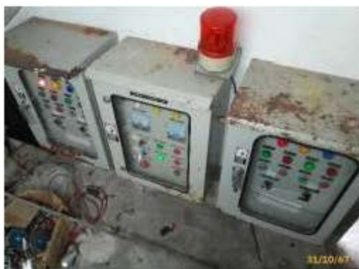
แผงควบคุมเครื่องสูบน้ำทิ้ง
